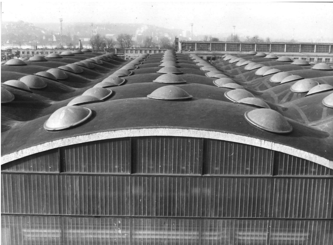
19. Csepel, Csepel Vas- és Fémművek, Szerszámgépgyár építése. Az kész épület homlokzatának és tetejének részlete. MIEA 11582
