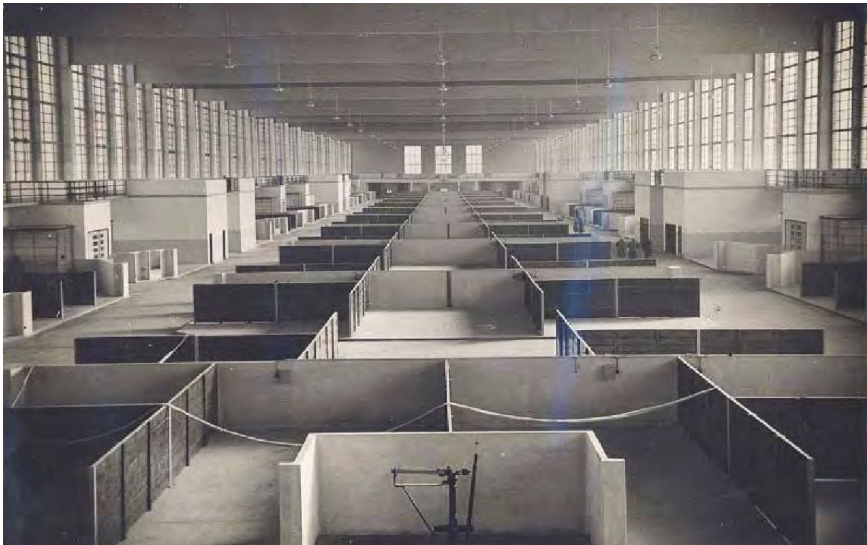
3. kép. Budapest IX. Nagyvásártelep. 42 m fesztáv. Obrist Vilmos 1933. (építész: Műnich Aladár). Forrás: FSZKT Budapest Gyűjtemény
