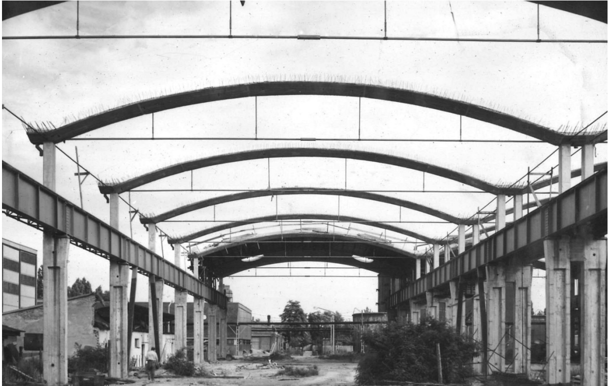
15. kép. Csepel, Csepel Vas- és Fémművek, Szerszámgyépgyár építése. Reisch Róbert (építész: Pál Balázs) 1967. Jól látható, hogy a korábban megépült megoldásokhoz képest mennyivel egyszerűbb a szerkezet. Az Y pillérek és a dupla íves gerendák helyett szimpla négyzetes keresztmetszetű pillérek, szimpla vonóvasas ív a kiinduló szerkezet. MIEA 8821
