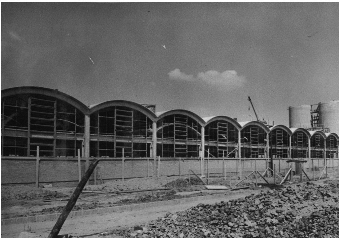
28. kép. Miskolc, Zsolca. Épületelemgyár. Homlokzati részlet építés közben. MIEA 5771
