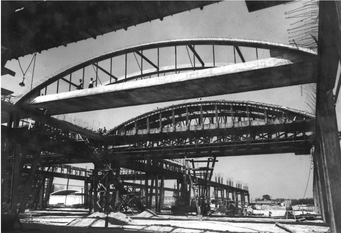
5. kép. Székesfehérvár, Könnyűfémmű Alumínium öntöde és prémű építése. Az íves tartók (és az alsó övökre épített síklemez építése a darupályára épített zsaluzaton. MIEA 3851
