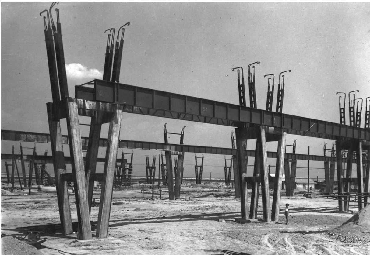
4. kép. Székesfehérvár, Könnyűfémű Alumínium öntöde és présű építése. Menyhárd István, építéstechnológia: Semsey Lajos, (építész: Farkas Ipoly) 1958-1960. 1 Y pillérek és darupálya építése. MIEA 3857
