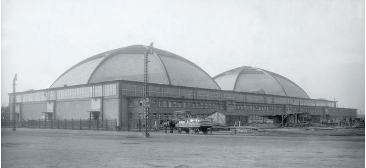
1. kép. Az úttörők munkái ismertek. Kevésbé ismert, de a magyar mérnökség által példának tekintett Franz Dischinger lipcsei nagyvásárcsarnoka. 75méter fesztávolságú, szegmensekből álló kupola. 1930. Forrás: Internet
