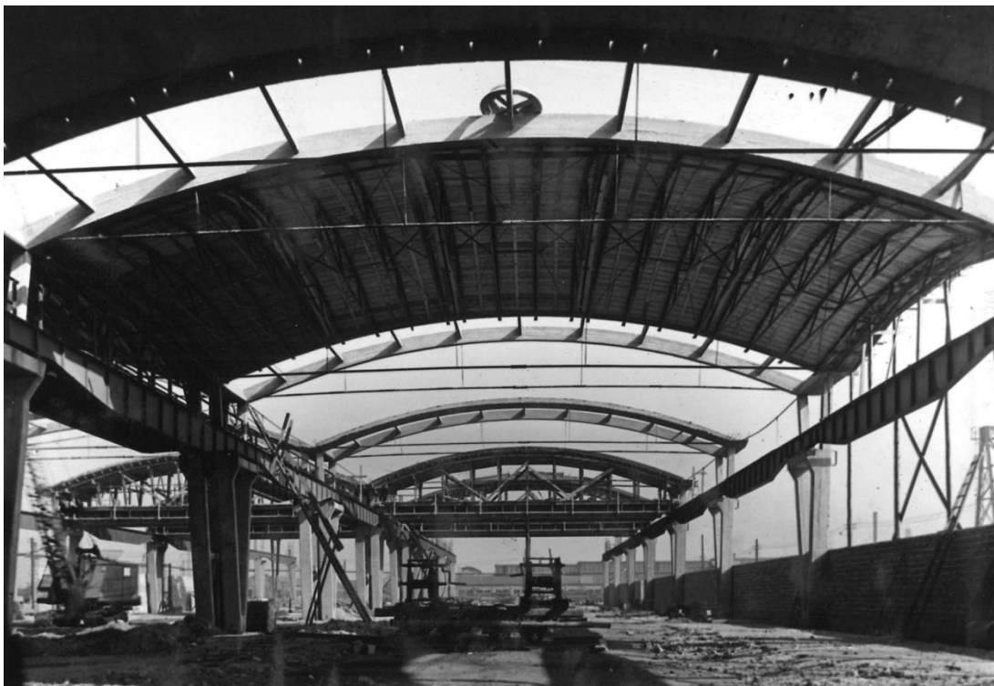
11. kép. Csepel, Csepel Vas- és Fémművek, Csőgyár üzemi csarnok építése. Az elkészült íves tartók közé feszül az elliptikus gyűrűfelület-szelet alakú domború héj. Jól látható, hogy itt is az íves tartókra a héj építéséhez már csak könnyű zsaluzatra volt szükség. MIEA 5090
