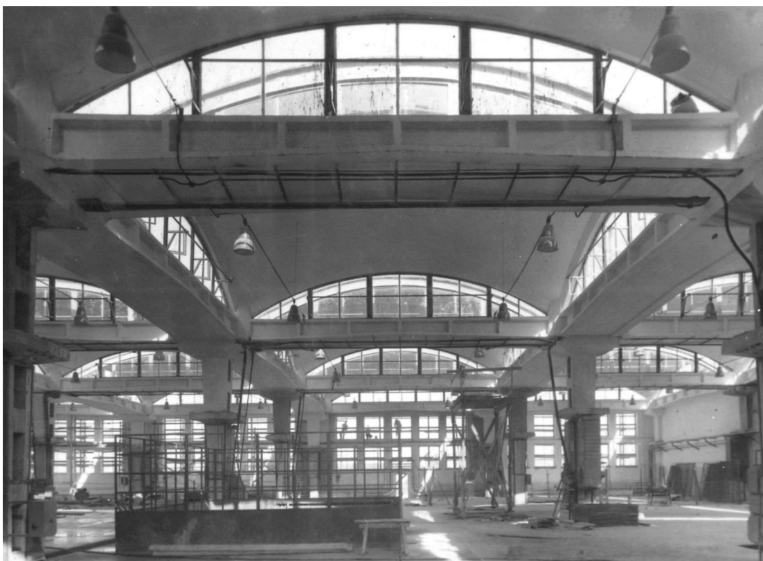
29. kép. Budapest XI. Kismotor- és Gépgyár csarnoka. 1960-krül. A négyzetes kiosztású hálózaton álló, széles fejű pilléreken dupla-dupla tartók. Az alsó övhöz sík mezők csatlakoznak, a felső övek gömbszelet boltozatok indító ívei. Az elrendezés kiváló bevilágítási körülményeket teremt. MIEA 5384
