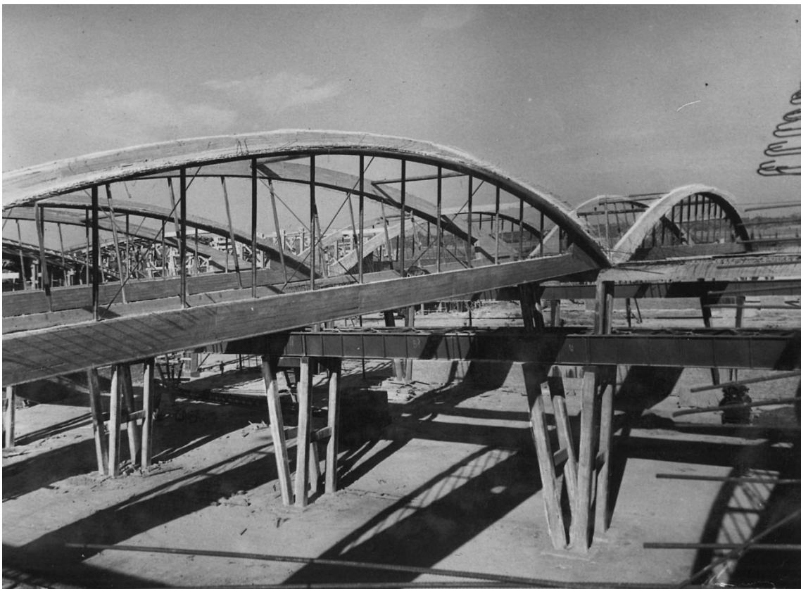
6. kép. Székesfehérvár, Könnyűfémmű Alumínium öntöde és prémű építése. A félkész lefedés. Az íves tartók felső öve között épül majd a befüggesztett héj. MIEA 3864
