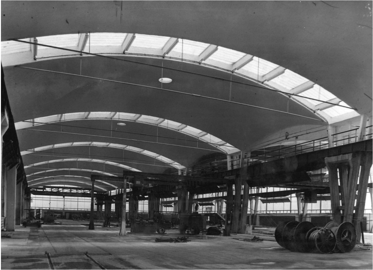
13. kép. Csepel, Csepel Vas- és Fémművek, Csőgyár üzemi csarnok építése. Az elkészült csarnok belső képe. MIEA 6018
